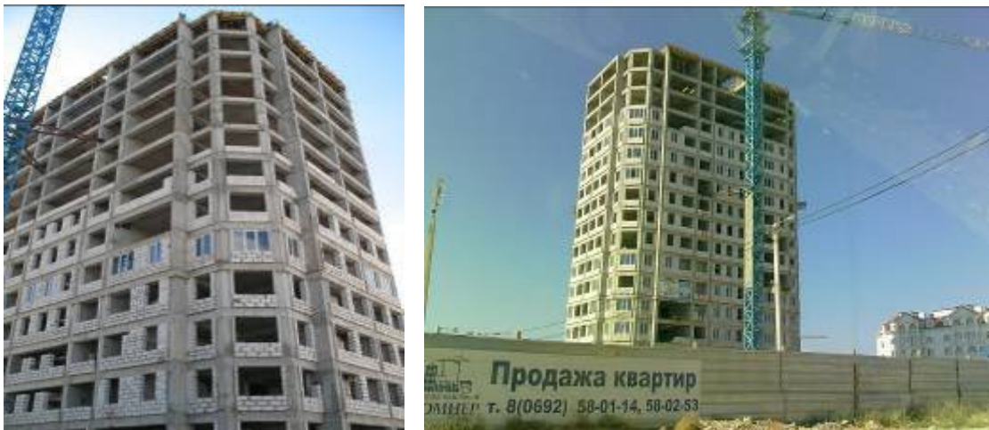
Стан виконання будівельних робіт по корпусу 6 в мікрорайоні «Омега-2а» у м. Севастополі станом на травень 2009 року та на кінець серпня 2009 року.
