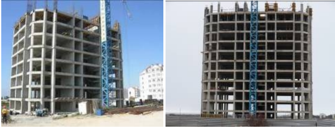
Стан виконання будівельних робіт по корпусу 6 в мікрорайоні «Омега-2а» у м. Севастополі станом на 05.09.2008 р. та на початок листопада 2008 року та станом на лютий 2009 року
