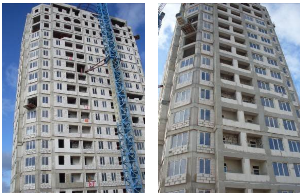
Стан виконання будівельних робіт по корпусу 6 в мікрорайоні «Омега-2а» у м. Севастополі станом на кінець листопада 2009 року
