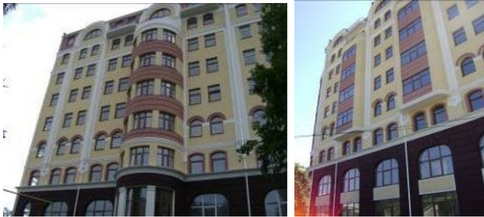
Хід робіт на об'єкті будівництва по вул. Баглікова у м. Алушті станом на початок червня 2009 року та кінець серпня 2009 року
