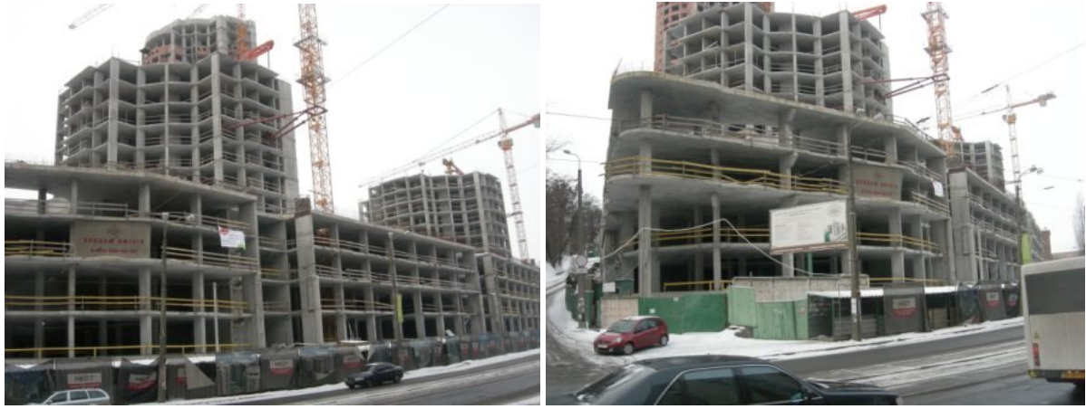
Рисунок 1. Будівельні роботи на об'єкті будівництва офісно-житлового комплексу в м. Києві на ділянці, обмеженої вулицями Глибочицькою, Студентською та Пимоненка станом на березень 2010 р.
