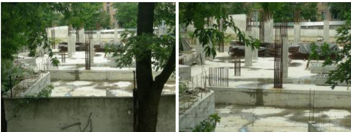
Хід робіт з будівництва багатоповерхового житлового будинку з вбудовано-прибудованими приміщеннями громадського призначення та підземного паркінгу по вул. Білоруській, 36-а у Шевченківському районі м. Києва станом на червень 2010 року
