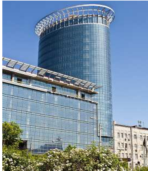
Об'єкт незавершеного будівництва по вул. Мельникова, 2/10, станом на початок травня 2012 року
