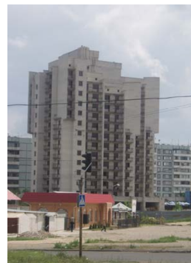
Будівництво житлового будинку станом на 22.04.2006 р. в м. Запоріжжя за будівельною адресою по вул. Маршала Судця, 26
