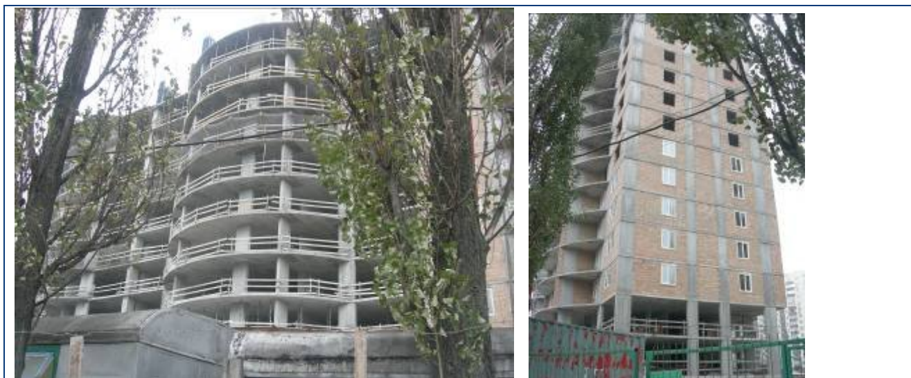
Будівельні роботи на секціях 1-3 житлового будинку № 26 станом на початок листопада 2009 року
