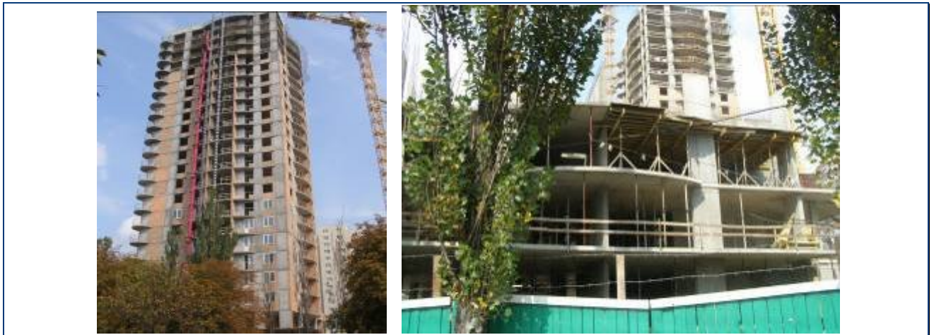
Будівельні роботи по житловим будинкам №№ 33 та 34 та № 35 станом на кінець серпня 2009 року
