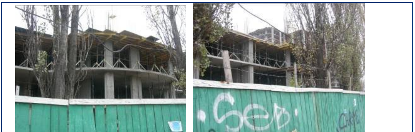
Будівельні роботи на секціях 1-4 житлового будинку № 28 станом на початок листопада 2009 року
