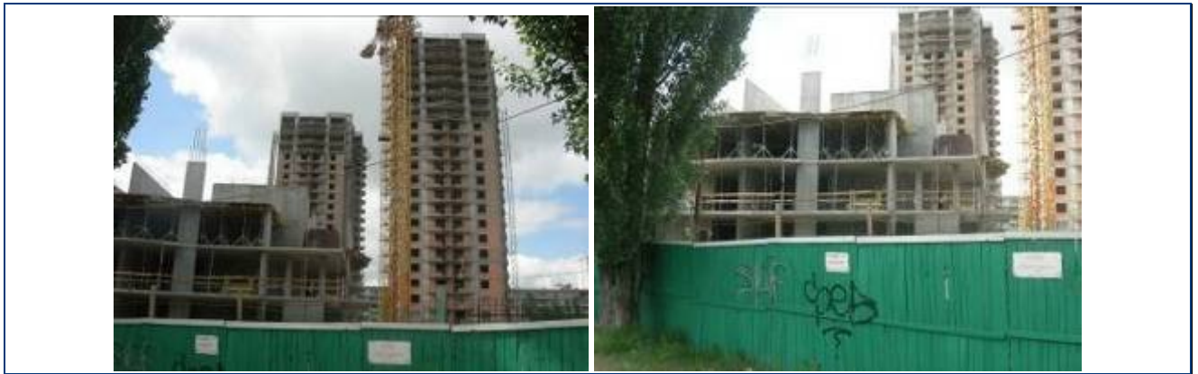
Будівельні роботи по житловим будинкам №№ 33 та 34 та № 35 станом на середину травня 2009 року
