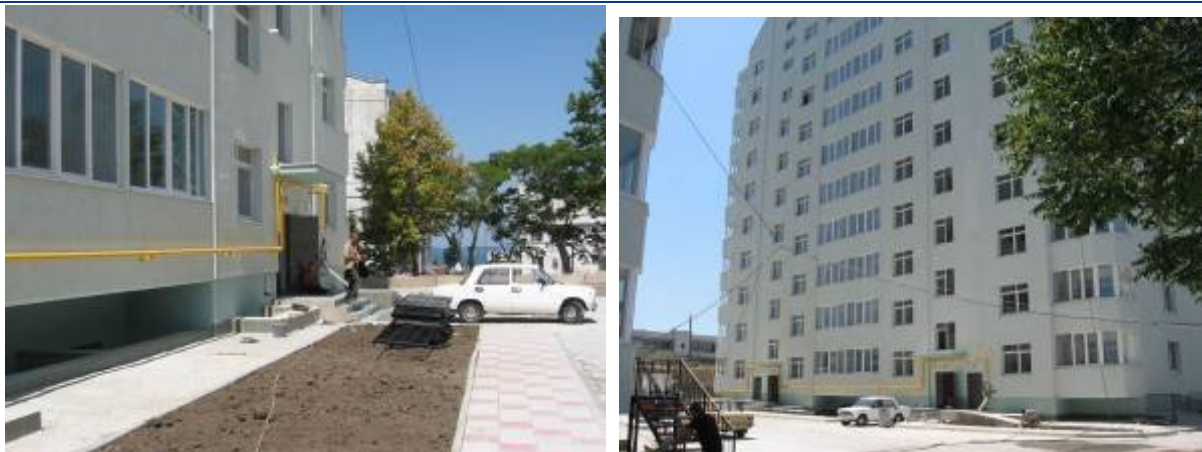
Стан будівництва 2-х житлових будинків по вул. Рєпіна, 19 у м. Севастополі станом на кінець липня 2009 р.
