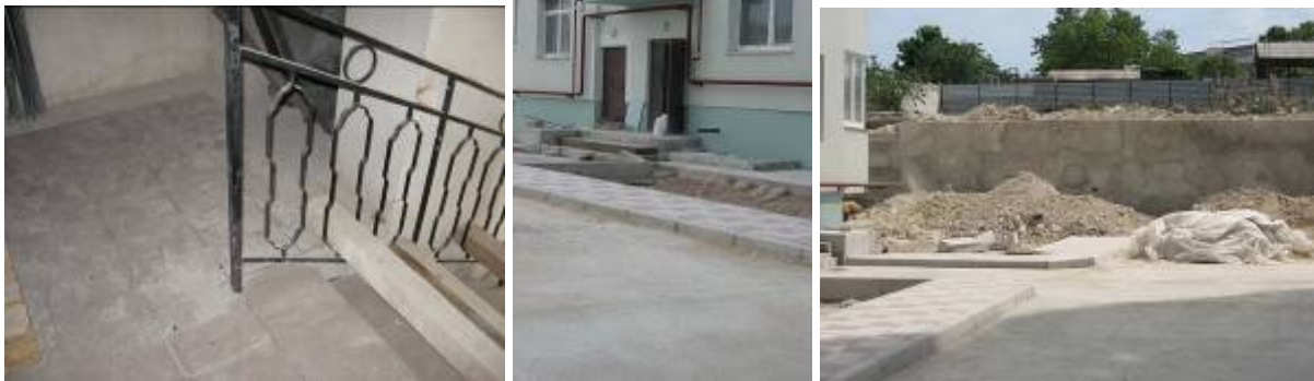
Стан будівництва 2-х житлових будинків по вул. Рєпіна, 19 у м. Севастополі станом на червень 2009 р.
