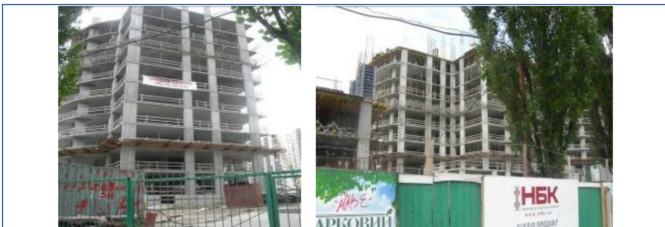
Будівельні роботи на секціях 1-3 житлового будинку № 26 станом на середину травня 2009 року
