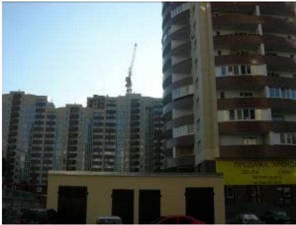
Секції 5-11 житлового будинку № 28
