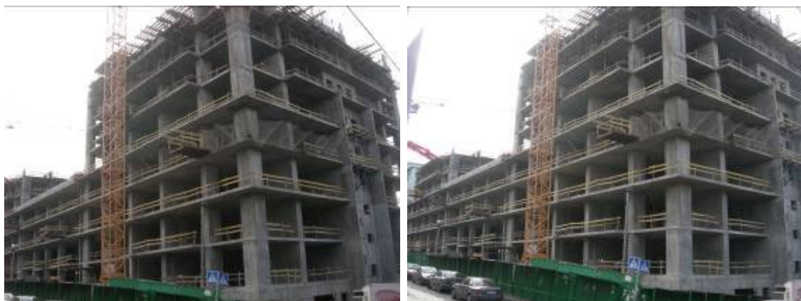
Будівельні роботи на об'єкті будівництва, обмеженого вулицями Предславинською, Ульянович та Червоноармійською станом на 17.11.2009 р.
