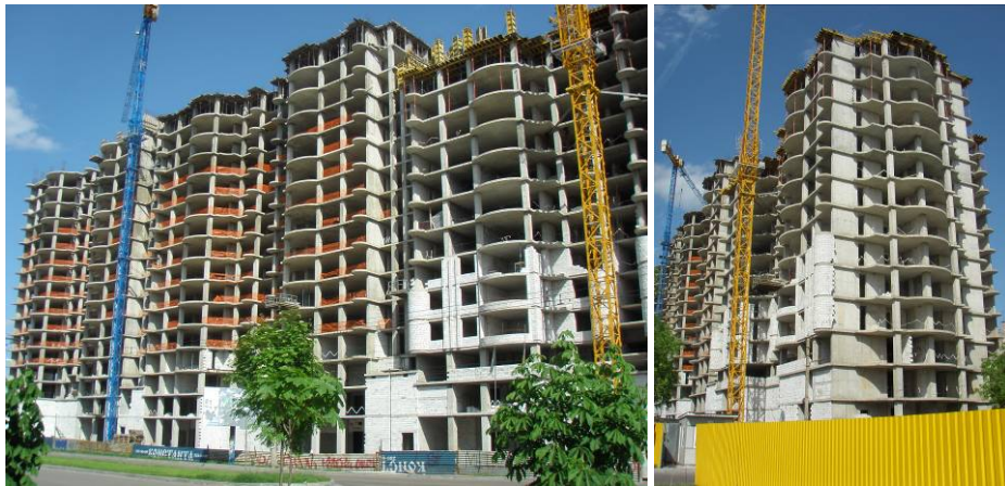
Будівельні роботи по вул. Бородинській – пров. Зірковому станом на середину травня 2009 року
