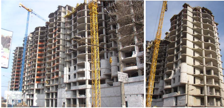
Будівельні роботи по вул. Бородинській – пров. Зірковому станом на середину лютого 2009 року
