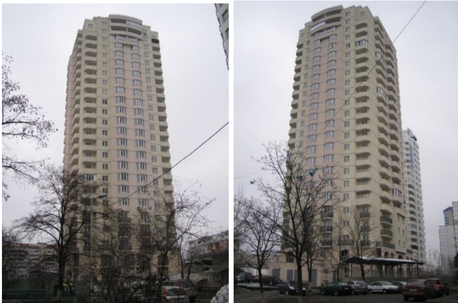
Рисунок 6/ Житловий будинок у м. Києві на розі вулиці Героїв Дніпра та проспекту Героїв Сталінграду станом на 02.12.2009 р.
