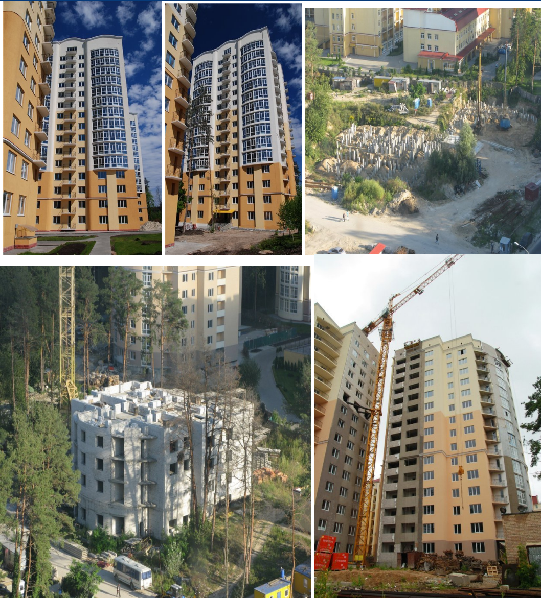
Рисунок 1. Будівництво житлового комплексу (II черга) по вул. Лобановського, 1 у с. Чайці Києво-Святошинського району Київської області станом на серпень 2011 року: будинки № 6, 7, 8, 9 та 10 (зліва направо)
