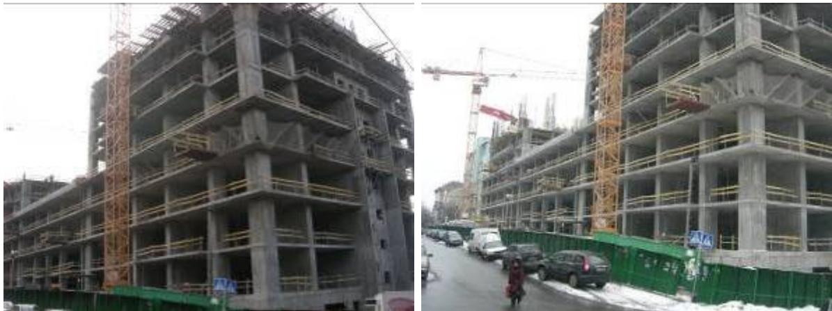
Рисунок 2. Будівельні роботи на об'єкті будівництва, обмеженого вулицями Предславинською, Ульянович та Червоноармійською станом на 17.11.2009 р. та станом на березень 2010 р.
