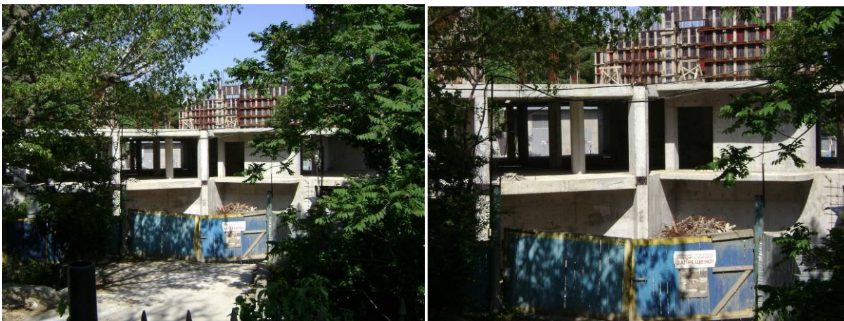
Рисунок 2.4. Хід будівництва рекреаційного комплексу по вул. Луговського в смт. Сімеїз станом на 04.06.2009 р.
