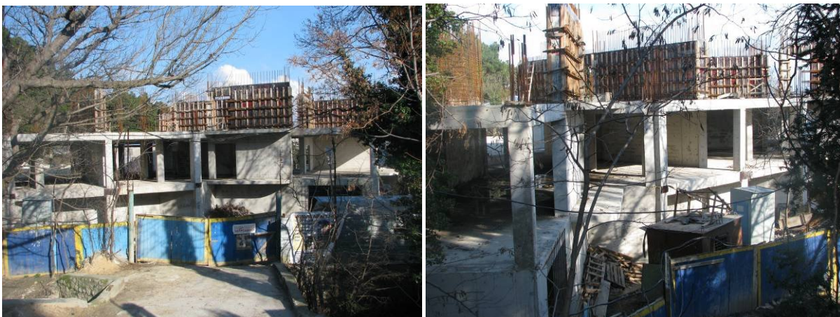
Рисунок 2.3. Хід будівництва рекреаційного комплексу по вул. Луговського в смт. Сімеїз станом на 20.02.2009 р.
