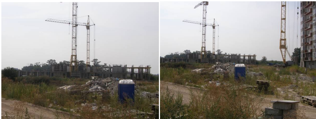
Рисунок 4. Стан будівництва житлових будинків у с. Чайці по вул. Коцюбинського, 29, 30 Київської області на 28.08.2009 р.
