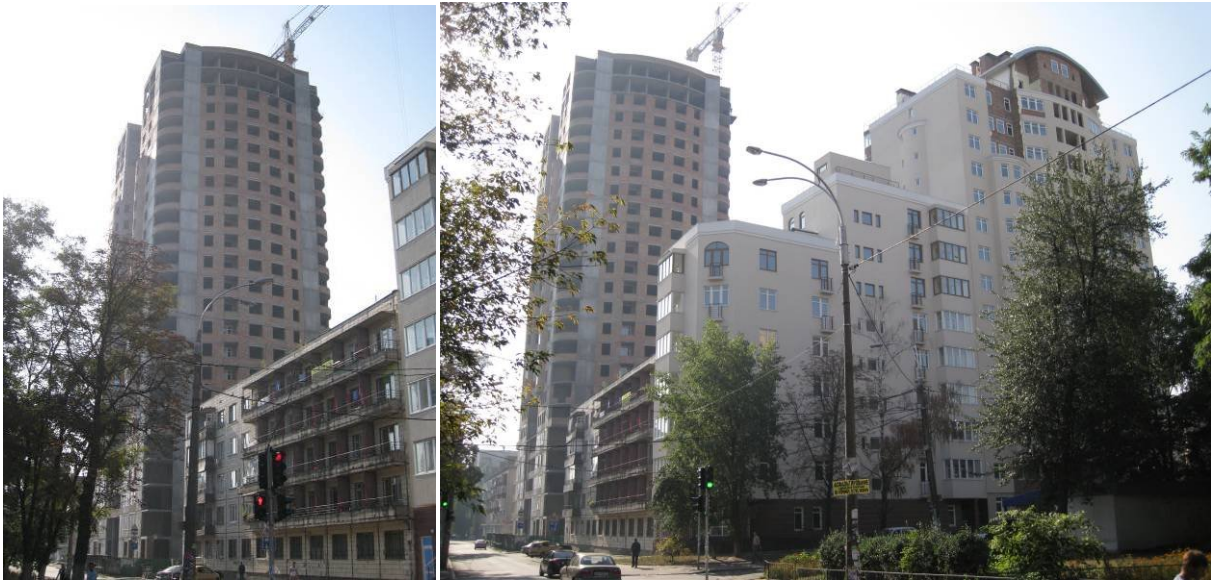
Рисунок 1. Стан будівництва житлових будинків №№ 1, 2, 4 по вул. М. Кривоноса та Климента на 16.09.2009 р.
