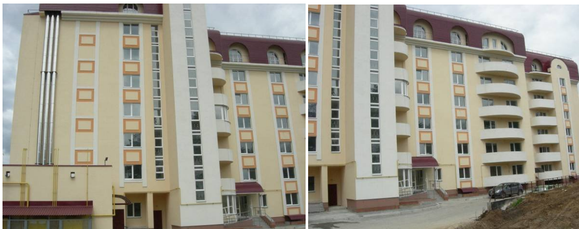
Рисунок 3. Житловий будинок у с. Чайці по вул. Коцюбинського буд. 6, Київської області
