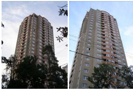
Хід робіт на об'єкті будівництва житлового будинку по вул. Львівській, 26 м. Київ станом на 24.06.2009 р.
