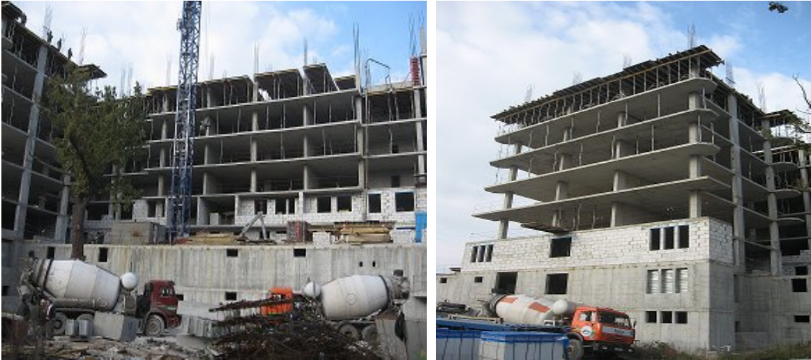
Стан будівництва житлового комплексу по вул. Фронтівій, 3 у м. Харкові станом на 15.10.2010 р.
