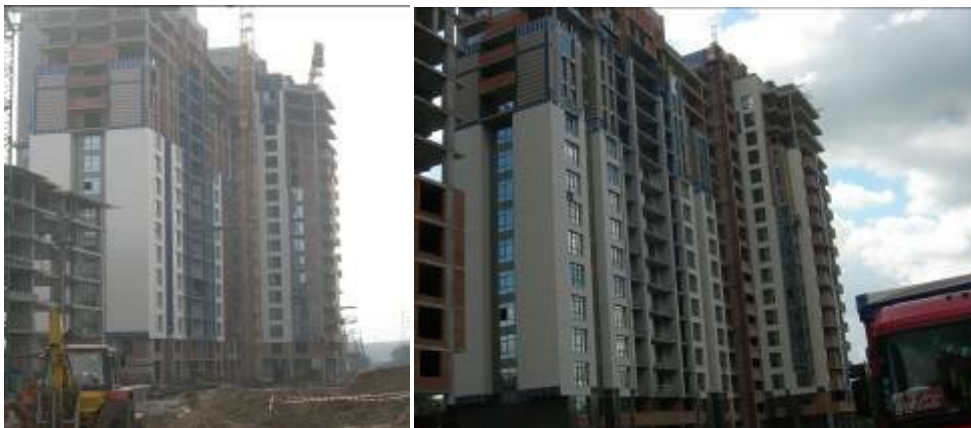
Хід робіт з будівництва ж/б 3 по вул. Професора Підвисоцького у Печерському районі м. Києва станом (зліва-направо): на 12.03.2009 р. та на 18.06.2009 р.
