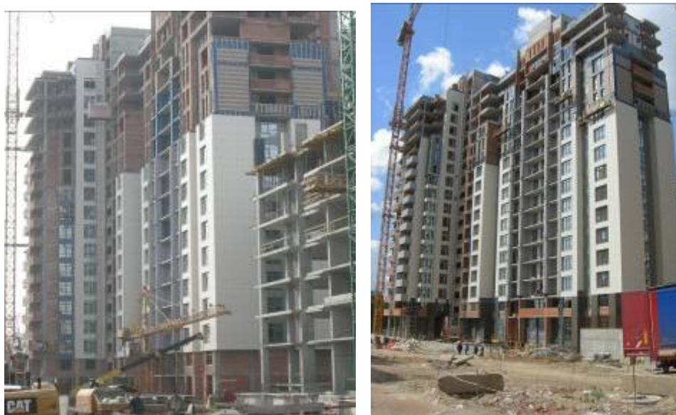
Хід робіт з будівництва ж/б 5 по вул. Професора Підвисоцького у Печерському районі м. Києва станом (зліва-направо): на 12.03.2009 р. та на 18.06.2009 р.
