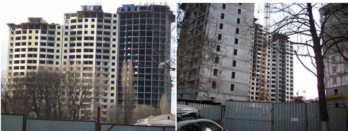
Будівництво житлового комплексу вул. Армієвської, 11 станом на 20.02.2009 р.
