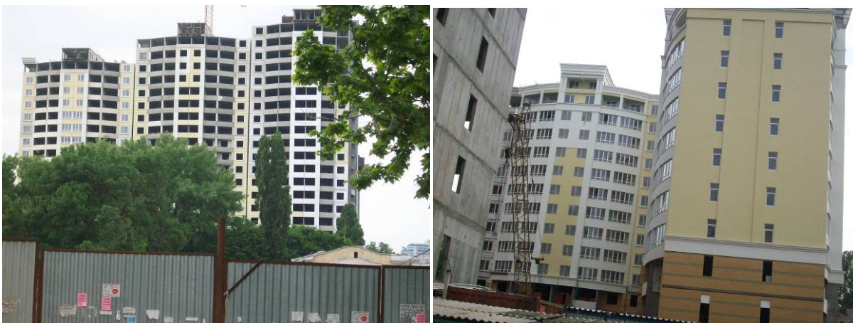
Будівництво житлового комплексу вул. Армієвської, 11 станом на 29.05.2009 р.
