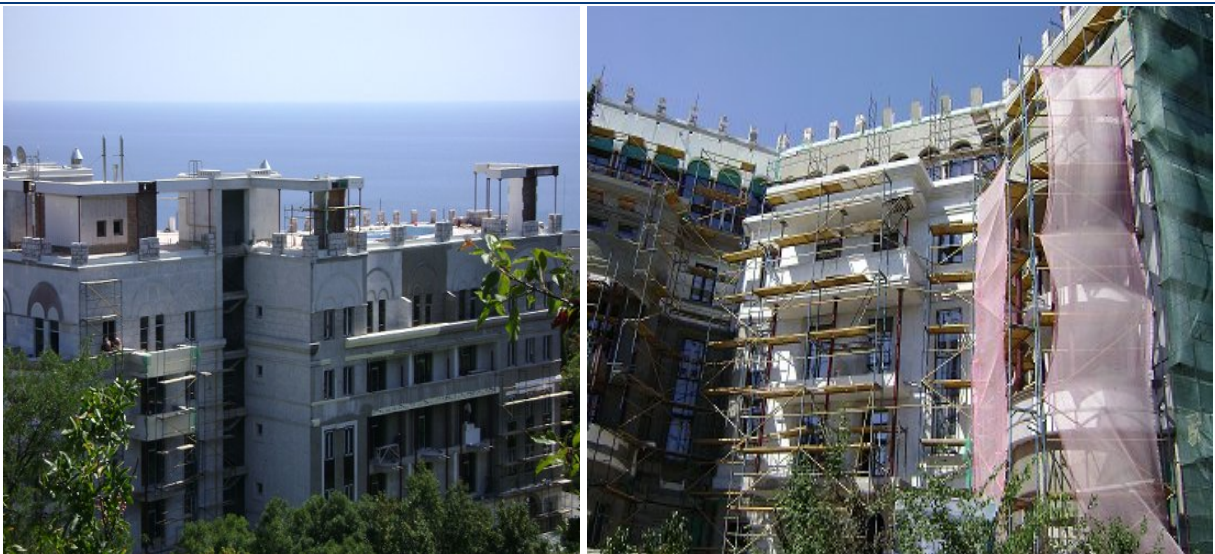
Стан будівництва житлового будинку по вул. Батуріна, 44А у смт. Лівадія м. Ялти станом на 27.08.2010 р.
