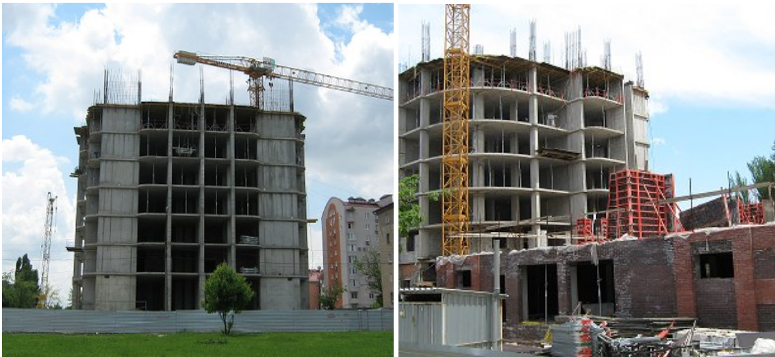
Хід будівництва житлового будинку на розі бульвару Шкільного та проспекту Миру в м. Донецьку станом на 29.05.2009 р.
