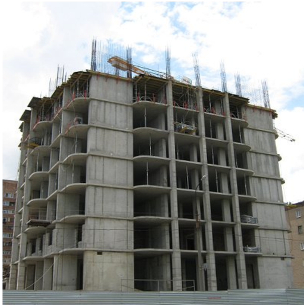
Хід будівництва житлового будинку на розі бульвару Шкільного та проспекту Миру в м. Донецьку станом на 20.08.2009 р.
