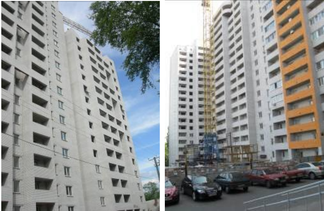
Об'єкт по вул. Дмитра Кедріна, в районі будинку №55, м. Дніпропетровськ станом на кінець травня 2009 року та на вересень 2009 року.
