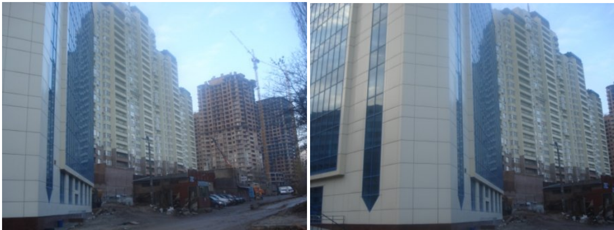
Рисунок 1. Житловий комплекс по вул. Механізаторів, 2 (ж/к «Времена года») у Солом'янському районі м. Києва
