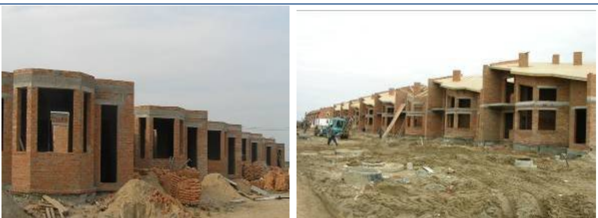
Рисунок 1.3. Об'єкти частини I черги (28 будинків загальною площею 3 825,72 кв. м, фінансування яких здійснюється за рахунок коштів ФОН «Нова Богданівка-1») житлового масиву «Нова Богданівка», станом на 5 вересня 2007 року та станом на березень 2008 року
