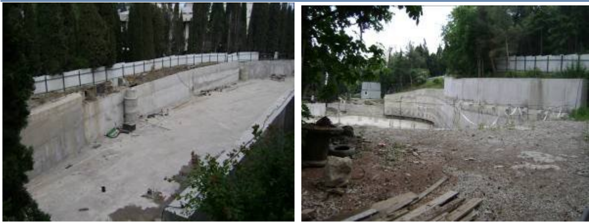
Стан будівництва за проектом реконструкції кінотеатру з добудовою рекреаційно-оздоровчого корпусу за адресою: АР Крим, смт. Гурзуф, вул. Ленінградська, 1 А станом на початок червня 2009 року
