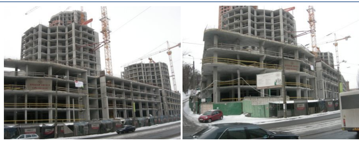
Будівельні роботи на об'єкті будівництва офісно-житлового комплексу в м. Києві на ділянці, обмеженій вулицями Глибочицькою, Студентською та Пимоненка
