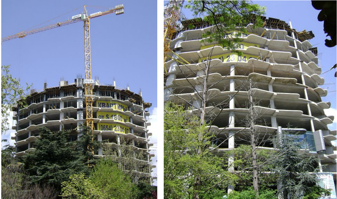
Будівництво багатоповерхового житлового будинку по вул. К. Маркса, 18а у м. Ялті станом на 06.05.2010 р
