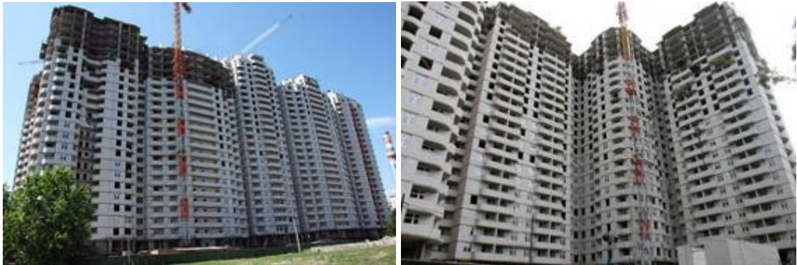
Рисунок 1. Будівельні роботи по вул. Майорова, 5А станом на середину липня 2009 року
