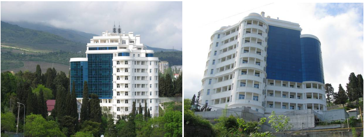
Житловий будинок у смт. Гурзуф по вул. Гурзуфське шосе, 8-б станом на 04.05.2009 р.
