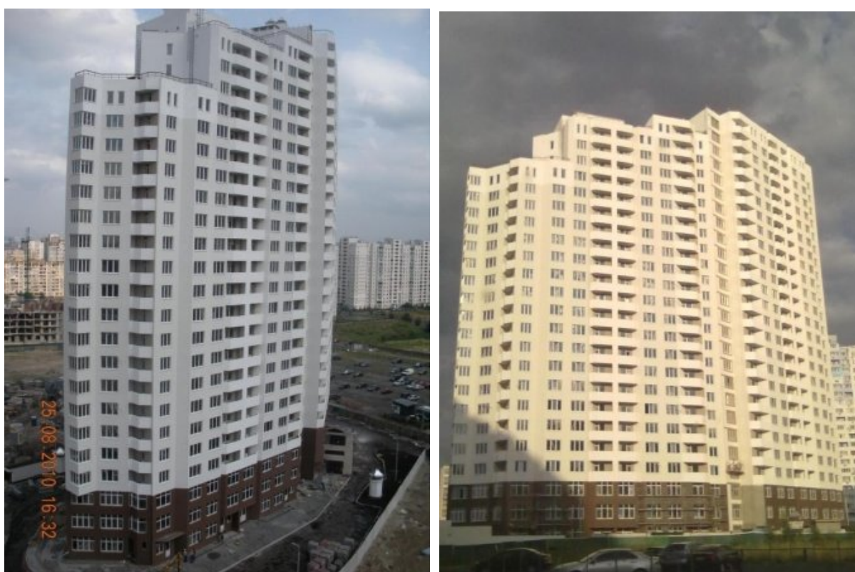
Рисунок 2. Стан будівництва житлового будинку по вул. О. Пчілки у 4-му м/н ж/м Позняки на 25.08.2010 р.
