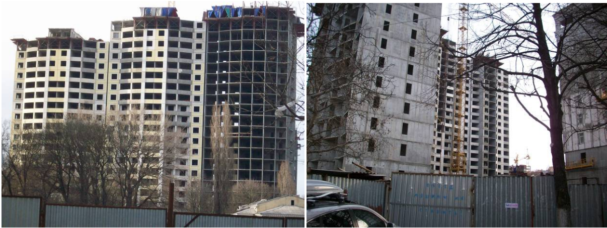
Будівництво житлового комплексу вул. Армієвської, 11 станом на 20.02.2009 р.
