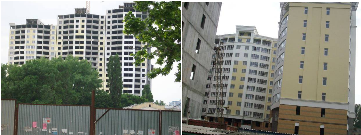
Будівництво житлового комплексу вул. Армієвської, 11 станом на 29.05.2009 р.
