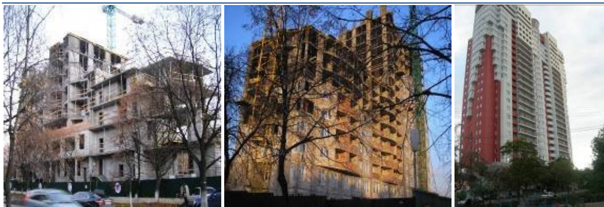
Хід робіт на об'єкті будівництва по вул. П. Запорожця, 26-А у м. Києві станом на початок листопада 2007 року, початок лютого 2008 року та вересень 2009 року (зліва направо)
