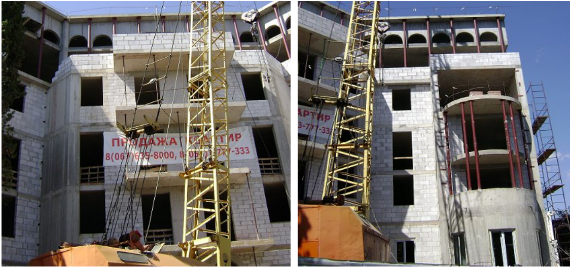
Стан будівництва житлового будинку по вул. Батуріна, 44А у смт. Лівадія м. Ялти станом на 21.08.2009 р.
