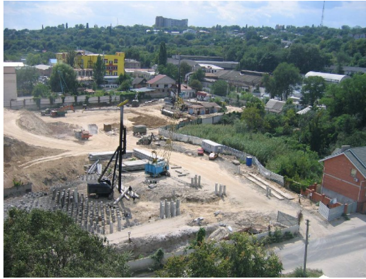
Хід робіт на об'єкті будівництва по вул. Мандриківській, 43 у м. Дніпропетровську станом на 18.08.2008 р.
