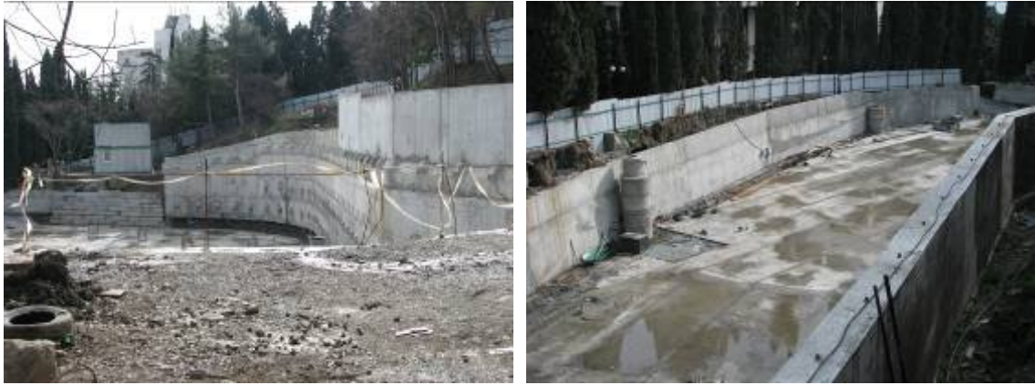
Рисунок 1.1. Стан будівництва за проектом реконструкції кінотеатру з добудовою рекреаційно-оздоровчого корпусу за адресою: АР Крим, смт. Гурзуф, вул. Ленінградська, 1 А станом на лютий 2009 року
