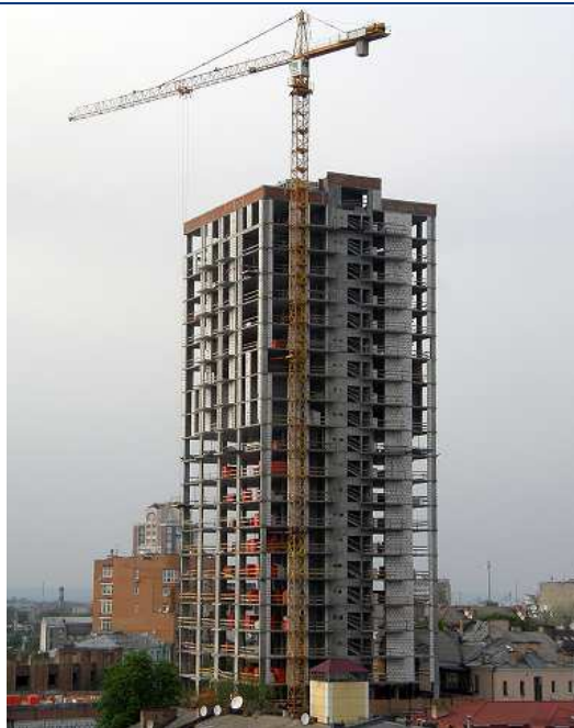
Хід будівництва житлово-офісного комплексу по вул. Воровського, 21 у м. Києві станом на середину травня 2013 року
