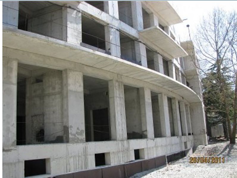
Хід робіт на об'єкті будівництва по вул. Ігнатенко, 9 у м. Ялті станом на 26.04.2011 р.
