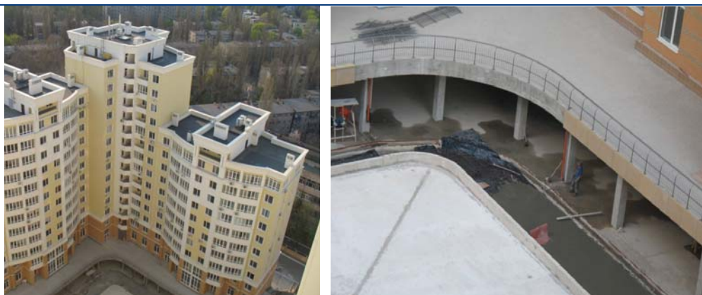
Хід будівництва житлового комплексу вул. Армійській, 11 станом на початок травня 2011 року
