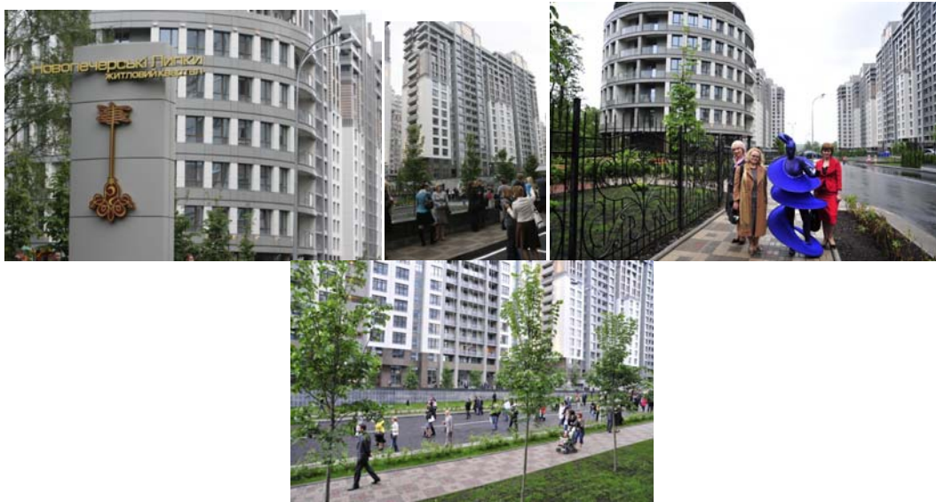
Житловий квартал по вул. Професора Підвисоцького у Печерському районі м. Києва (I черги будівництва)
