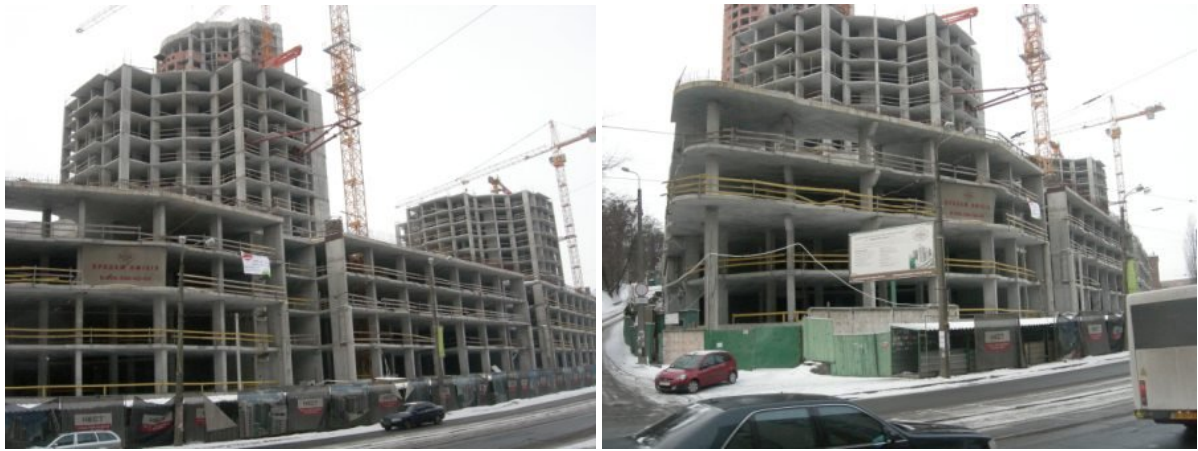
Рисунок 1. Будівельні роботи на об'єкті будівництва офісно-житлового комплексу в м. Києві на ділянці, обмеженої вулицями Глибочицькою, Студентською та Пимоненка станом на березень 2010 р.
