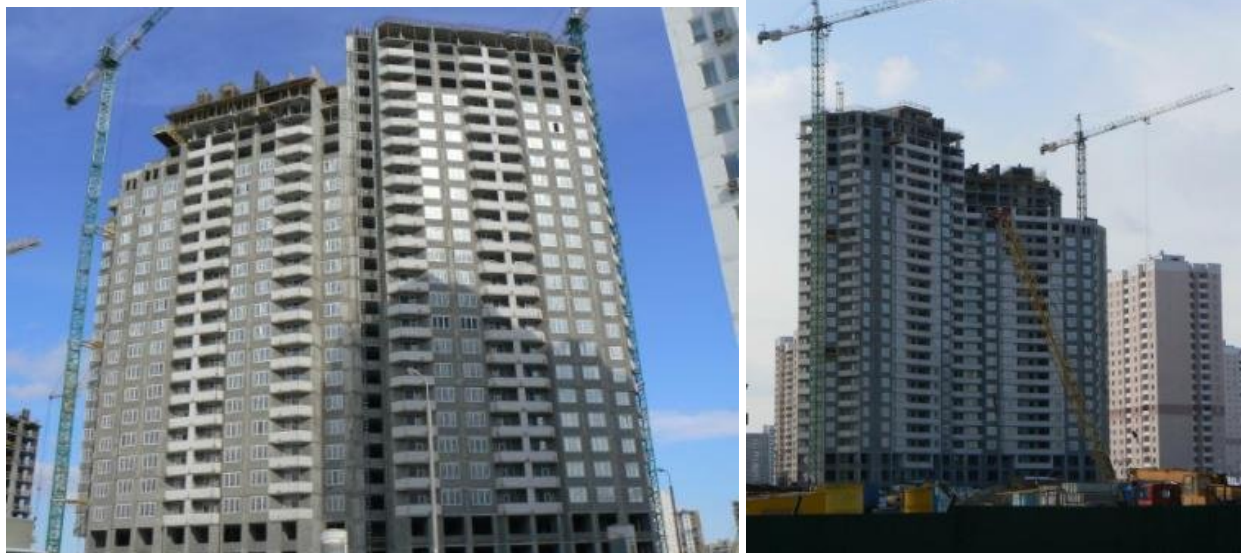
Рисунок 2. Стан будівництва житлового будинку по вул. О. Пчілки у 4-му м/н ж/м Позняки на червень 2010 р.
