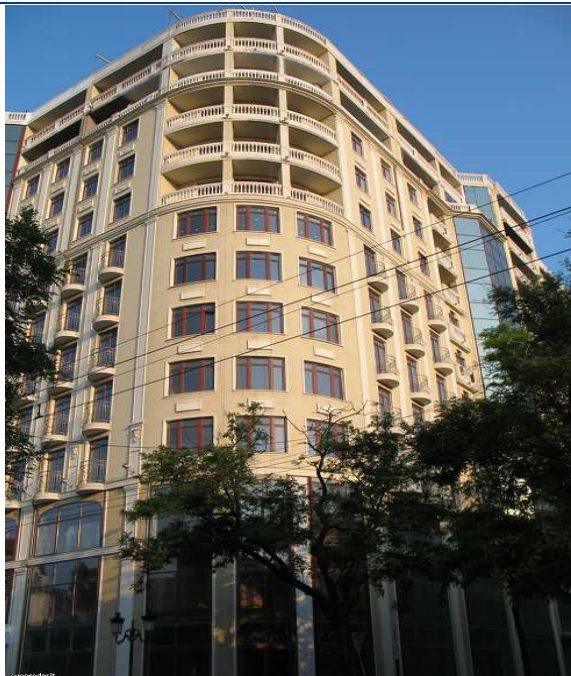
Житлово-торговельний комплекс по вул. Грецькій, 1 у м. Одесі
