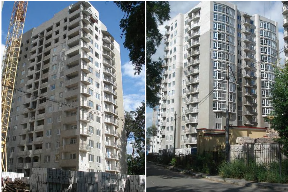
Будівництво житлового комплексу (II черга) в Київській області с. Чайки по вул. Лобановського, 1 станом на 01.08.2009 р.
