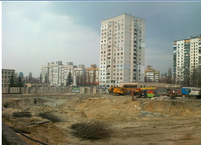
Хід робіт на об'єкті будівництва житлово-офісного комплексу з вбудовано-прибудованими торговельними приміщеннями, закладами громадського харчування та підземною автостоянкою по вул. М. Островського, 40 у м. Києві станом на 29.03.2011 р.
