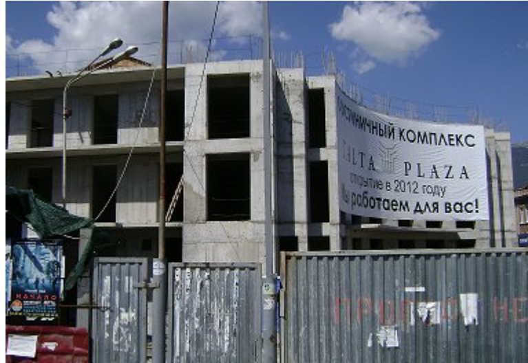
Хід робіт на об'єкті будівництва по вул. Ігнатенко, 9 у м. Ялті станом на кінець вересня 2010 року
