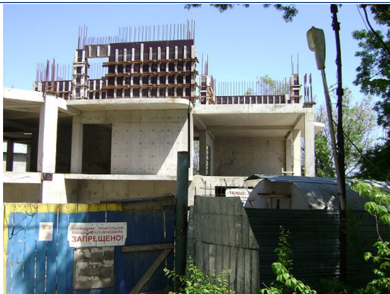
Хід будівництва рекреаційного комплексу по вул. Луговського в смт. Сімеїз станом на 06.05.2010 р.
