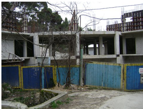
Хід будівництва рекреаційного комплексу по вул. Луговського в смт. Сімеїз станом на 04.03.2010 р.
