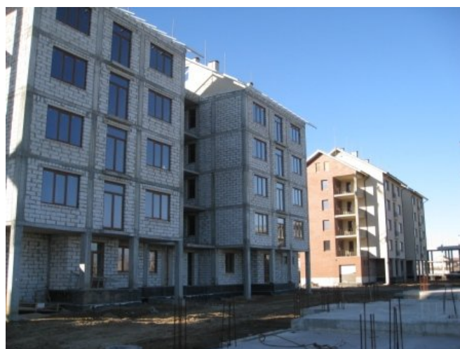
Рисунок 1.3. Житловий будинок №4 по вул. Медичній у м. Запоріжжі станом на березень 2010 року
