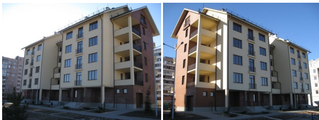
Рисунок 1.4. Житловий будинок №5 по вул. Медичній у м. Запоріжжі
