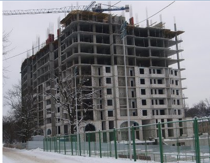
Стан будівництва житлового комплексу по вул. Фронтовій, 3 у м. Харкові станом на 18.01.2011 р.
