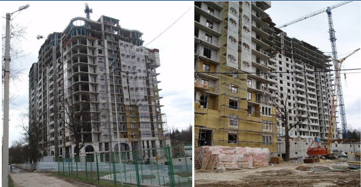
Стан будівництва житлового комплексу по вул. Фронтовій, 3 у м. Харкові станом на кінець квітня 2011 року
