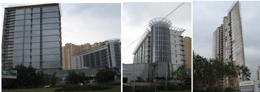
Будівельні роботи на об'єкті «Артеміда» за адресою м. Київ, перехрестя Дарницького бульвару та вул. Генерала Жмаченка станом на вересень 2011 р.
