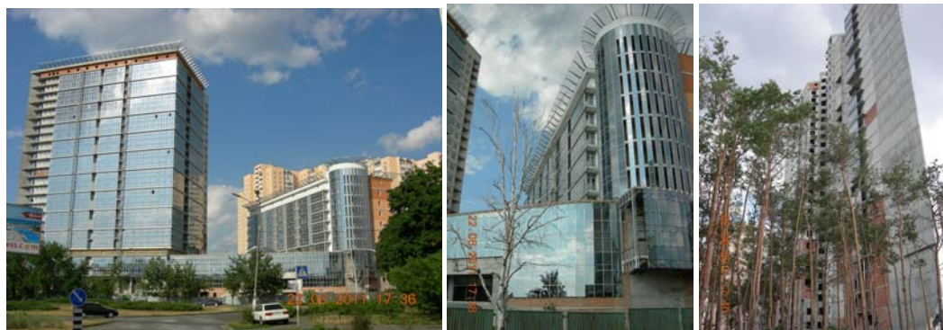
Будівельні роботи на об'єкті «Артеміда комплекс» за адресою м. Київ, перехрестя Дарницького бульвару та вул. Генерала Жмаченка станом на червень 2010 р.
